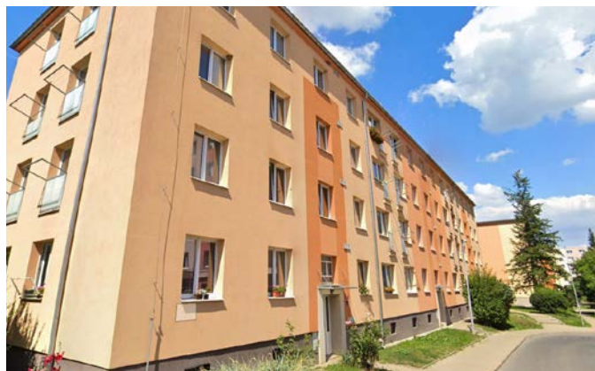
Jeden z dotčených panelových domů
